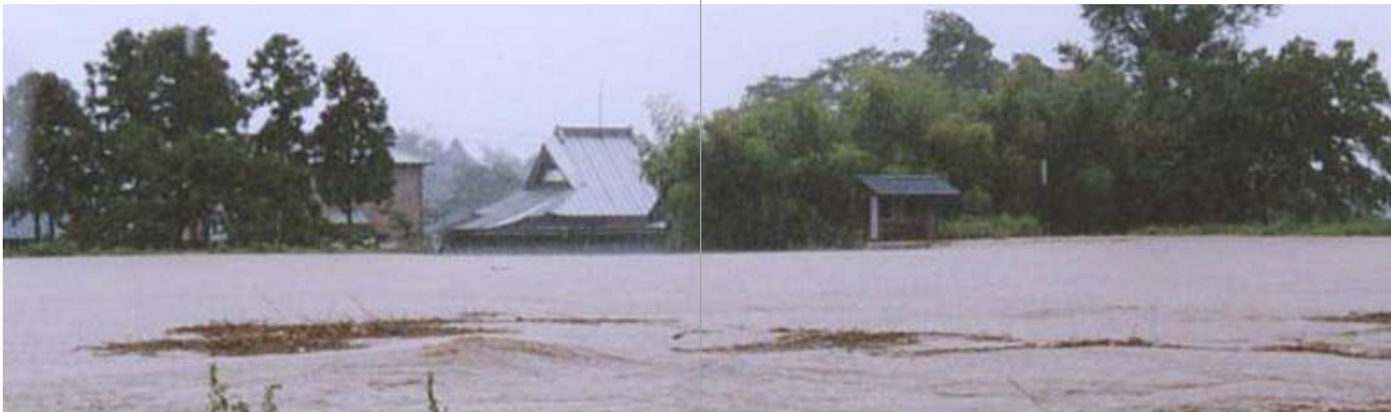
刈谷田川の破堤状況
