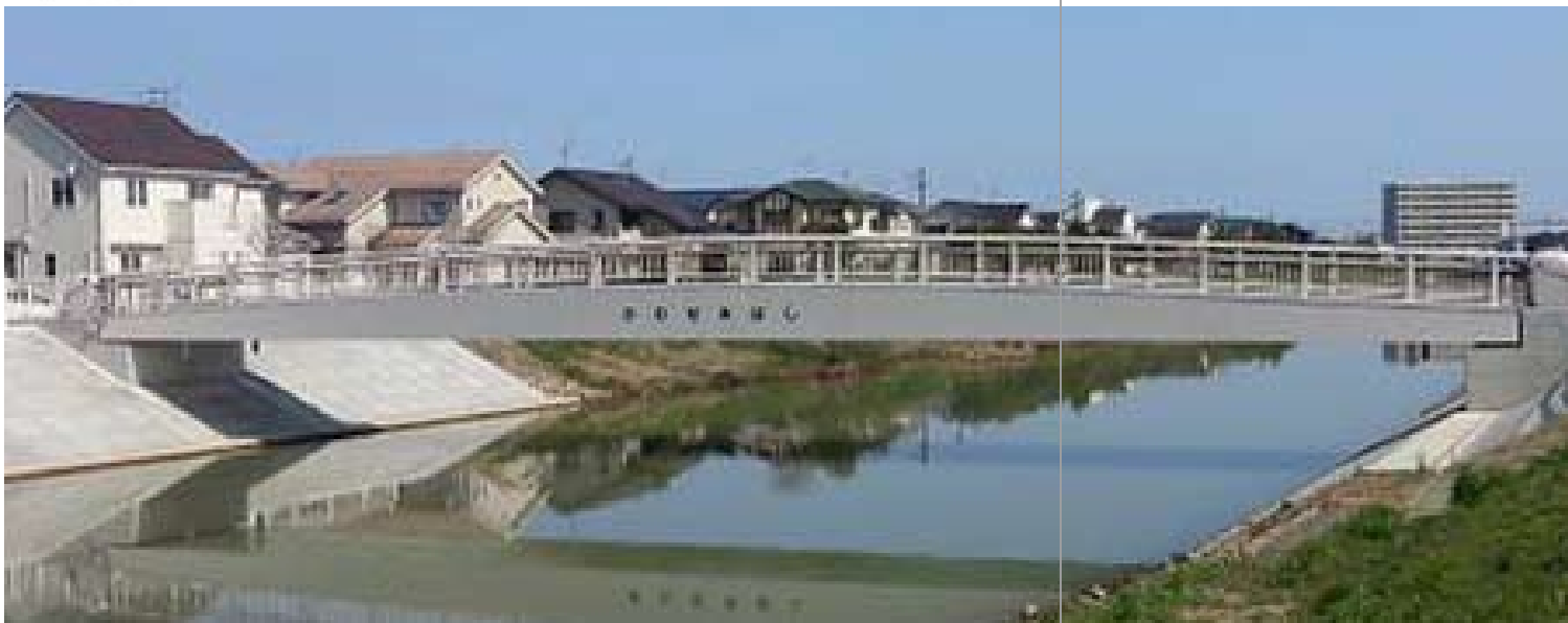
通船川かわせみ橋
