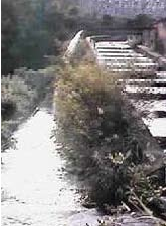
鹿瀬ダムの魚道
